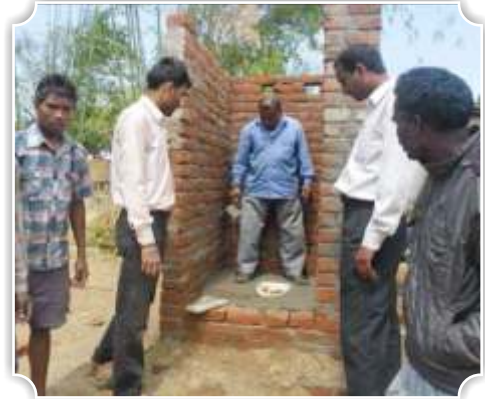
चबूतरा का निर्माण जमीन से 2-3 रद्दा ऊपर बनायें, ताकि बरसात का पानी अन्दर प्रवेश न करें।
